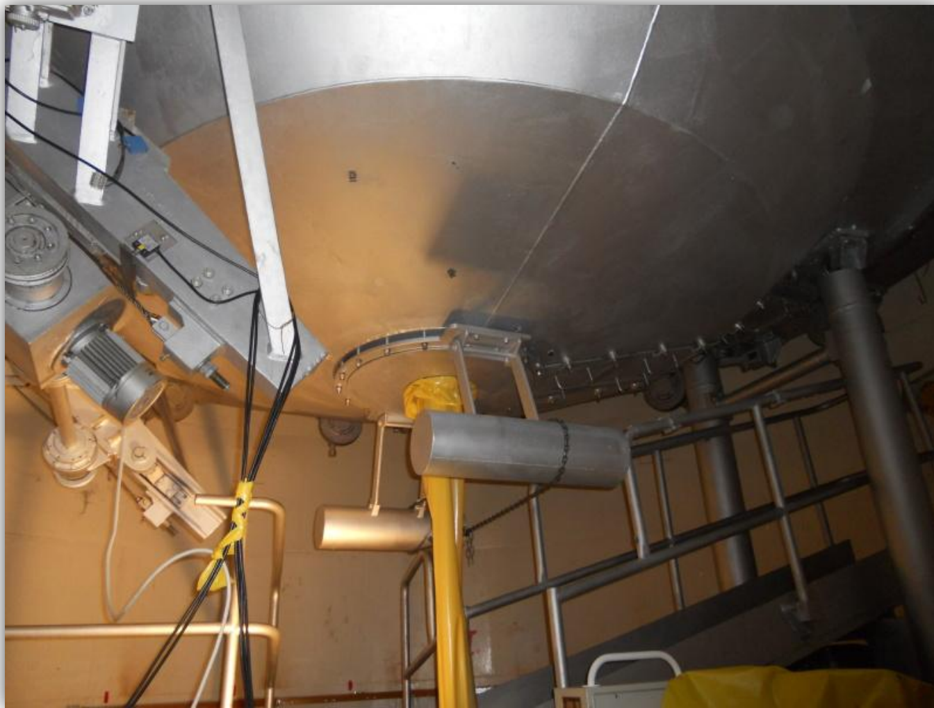
Plavákový mechanizmus na otvorenie veka v tepelnej izolácii TNR
